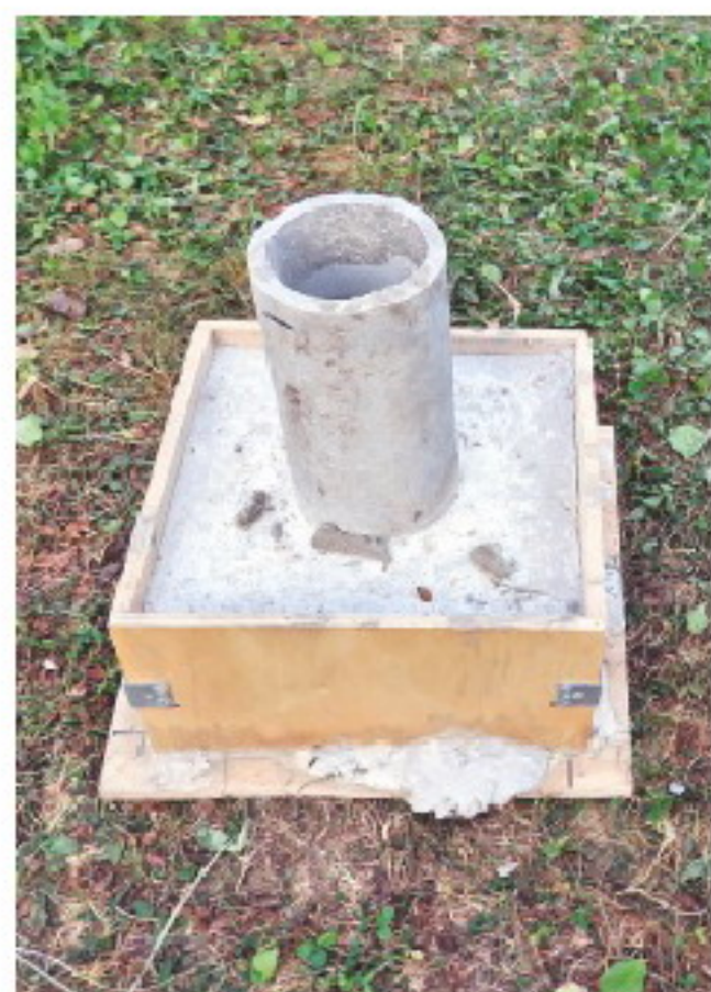
«Тапки» сохли две недели, опалубку можно снимать.
