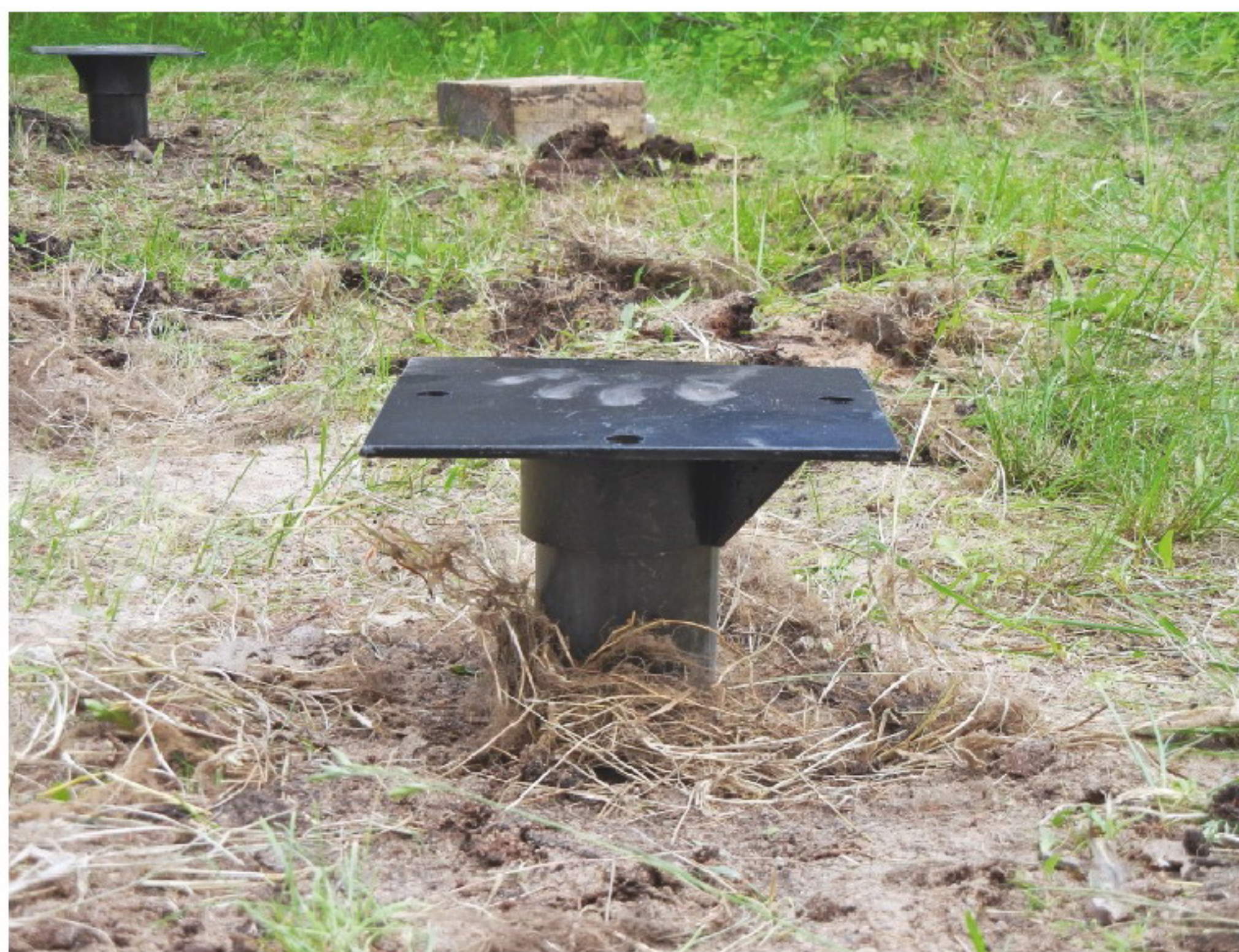
Оголовок винтовой сваи
