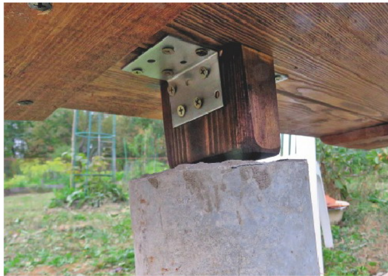
Устанавливаем сидение, чурбаки плотно входят в трубы. И сидение надежно зафиксировано.
