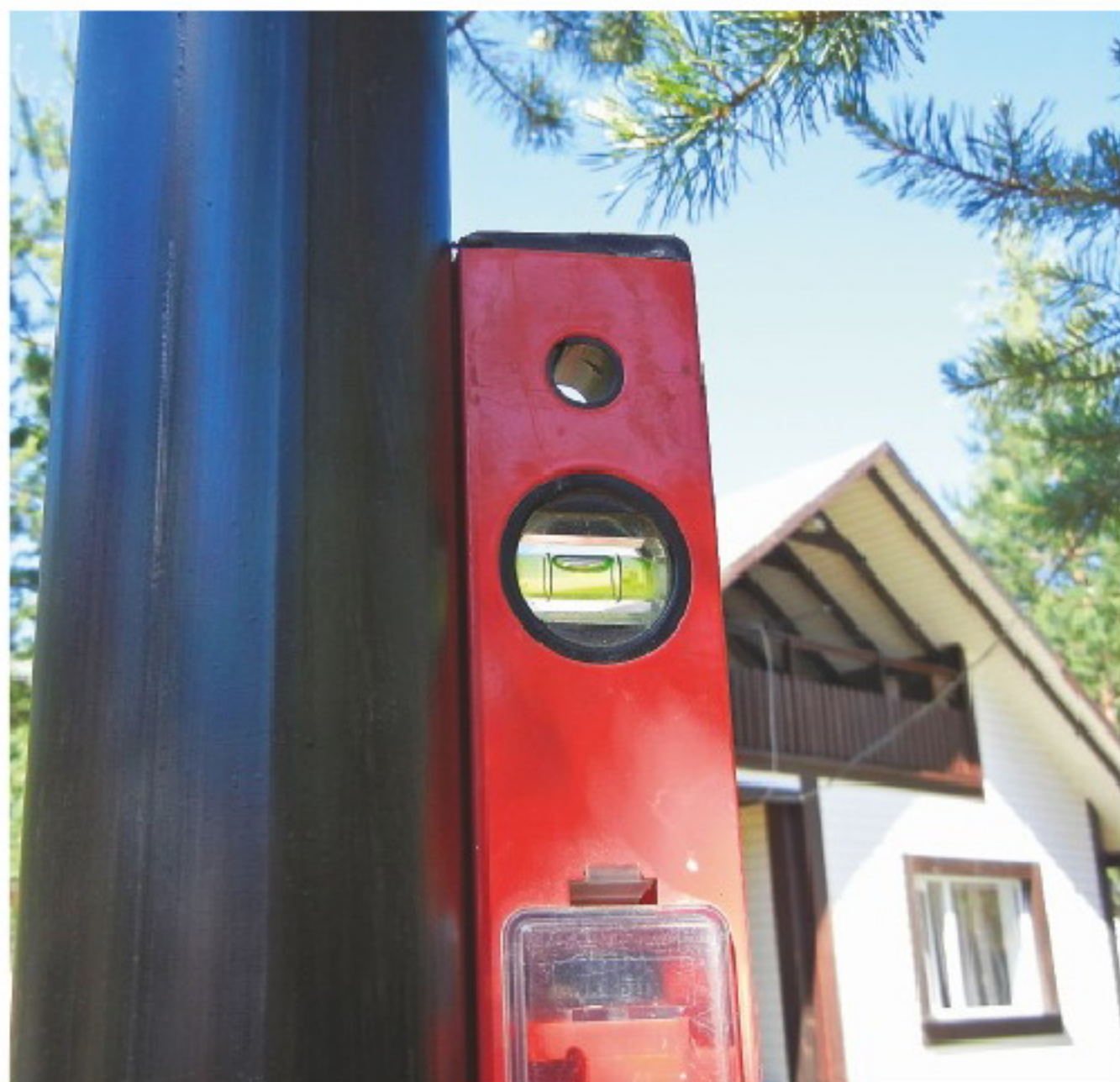
Контроль вертикального положения винтовой сваи
