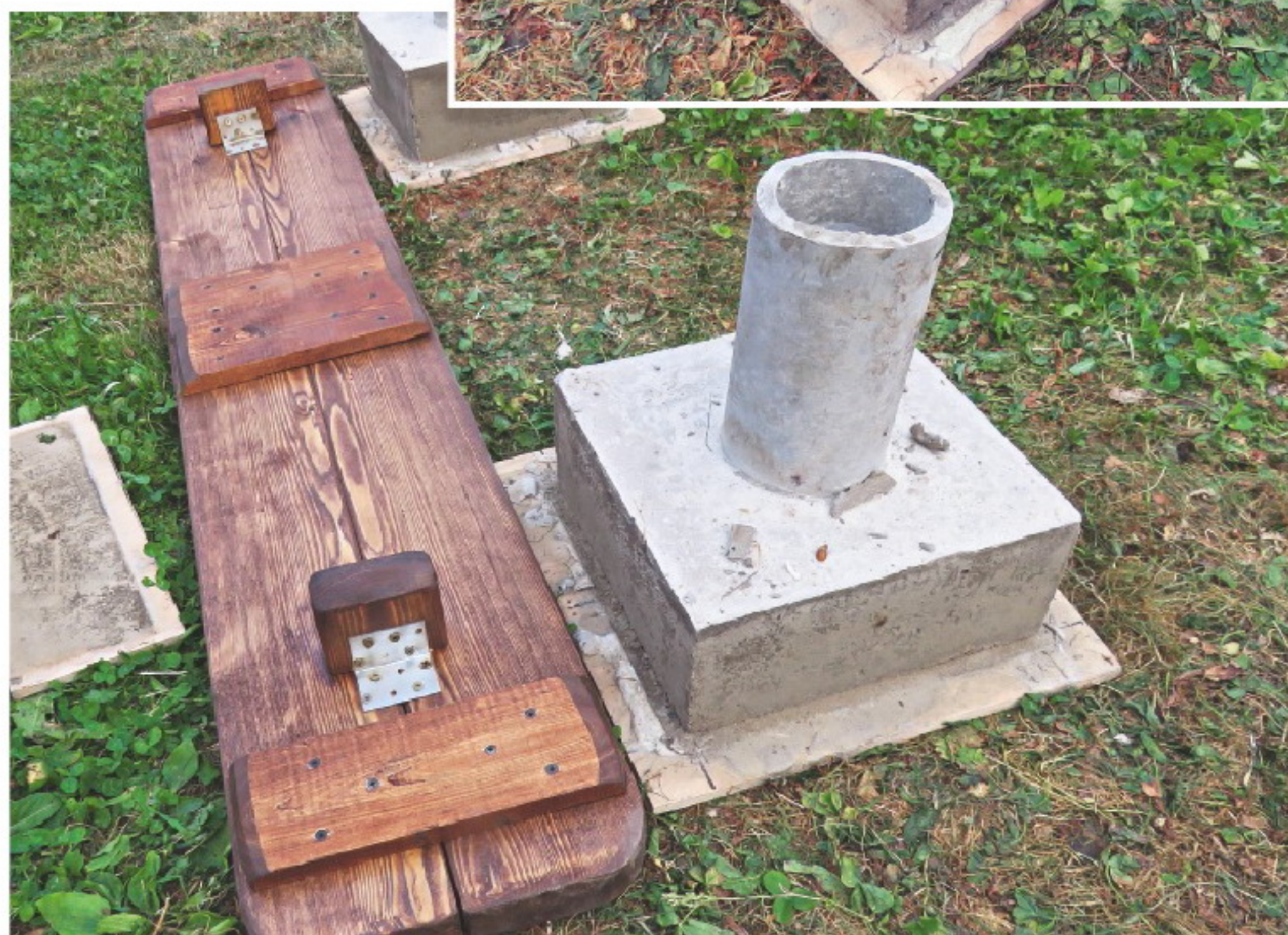
Устанавливаем ножки на нужном расстоянии, вес каждого «тапка» получился более 30 кг, можно было и тоньше сделать.
