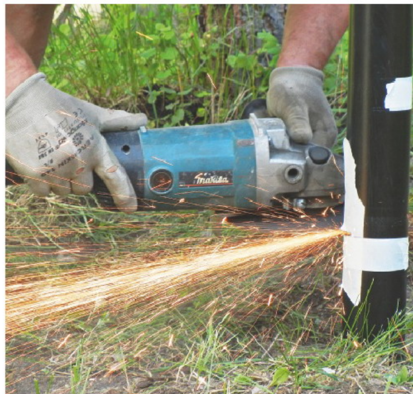
Обрезка винтовой сваи по уровню
