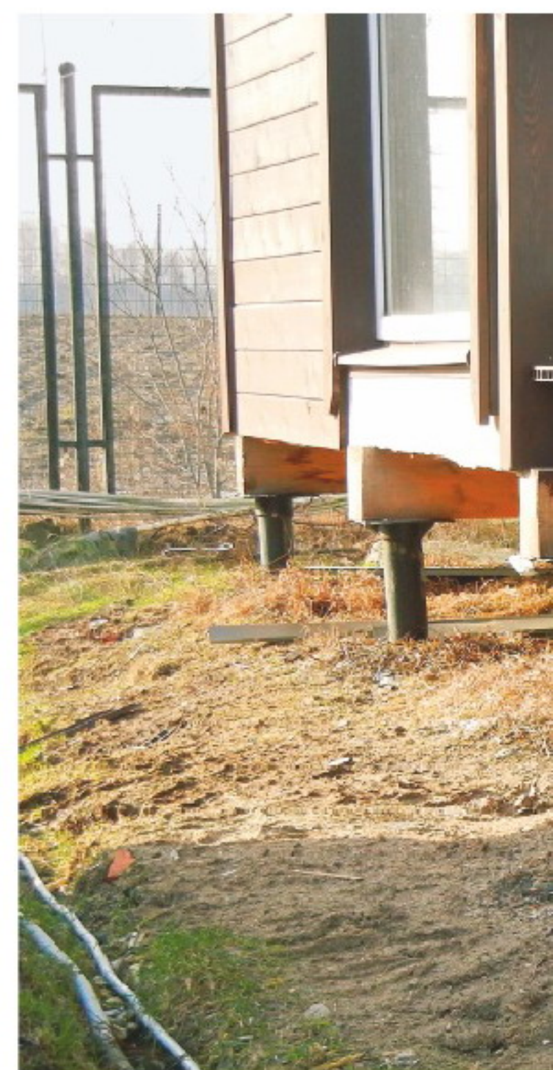
Порошково-полимерная защита винтовой сваи
