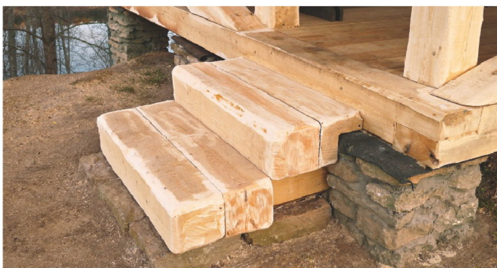
Беседка на бутобетонных столбиках
