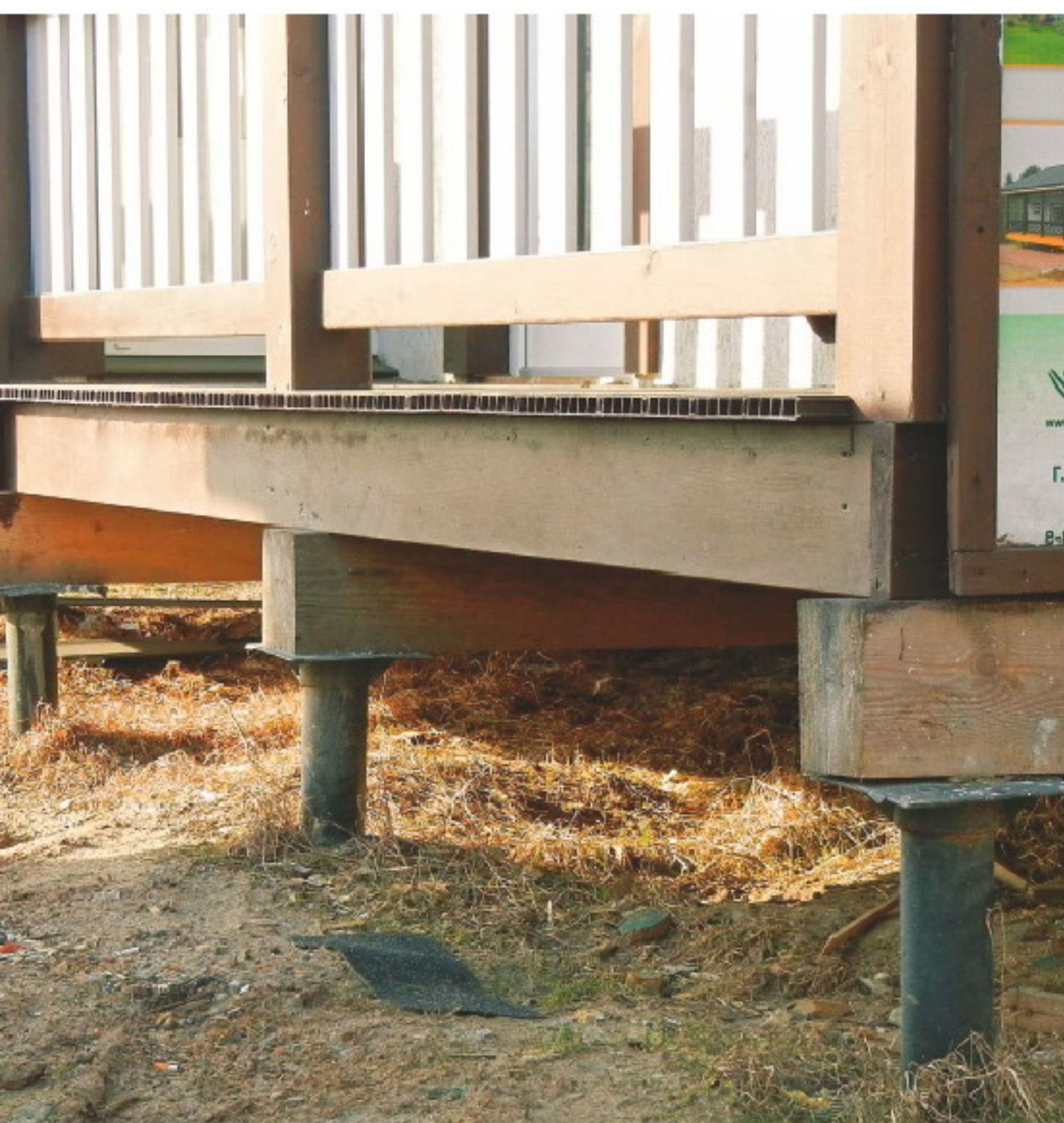
Временная постройка на винтовых сваях
