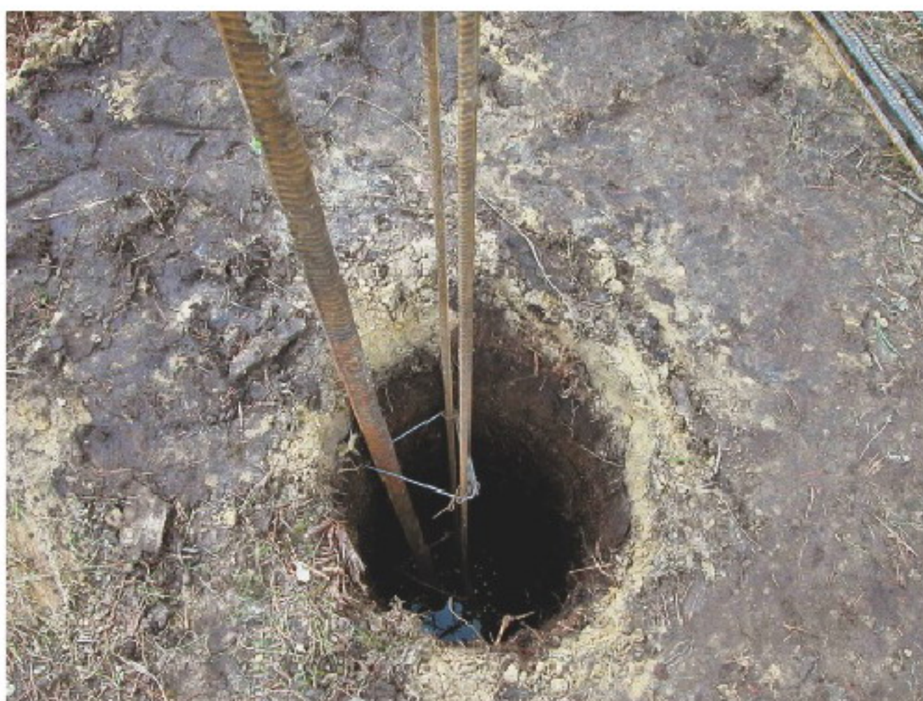
Скважина для буровой сваи с арматурным каркасом
