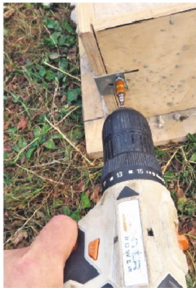
Выкручиваем шурупы и освобождаем отливку.
