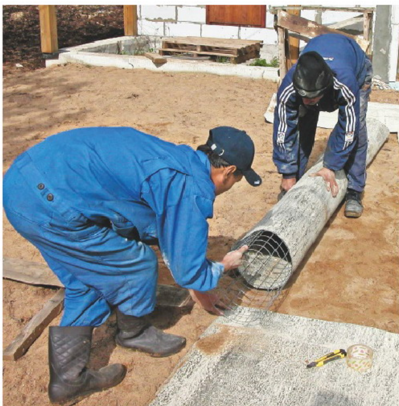
Подготовка мягкой опалубки для буровой сваи
